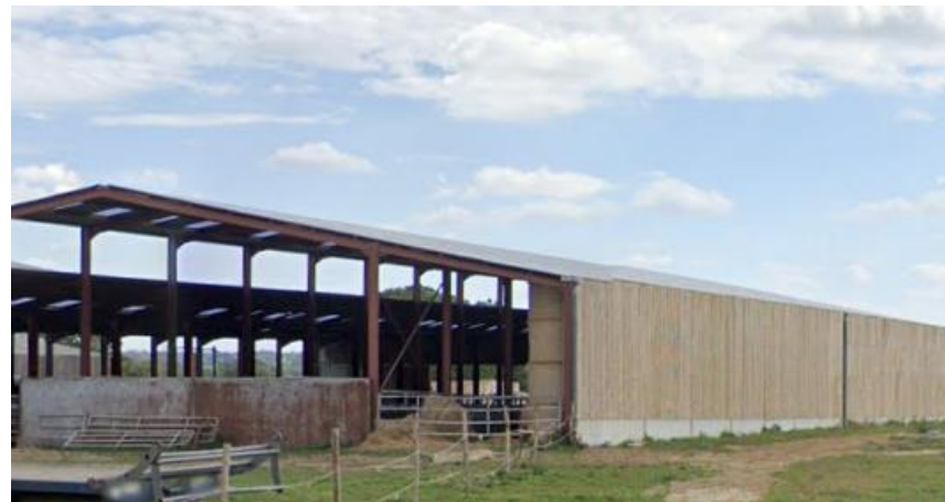
Figure 2 : Photo du bâtiment vaches laitières
