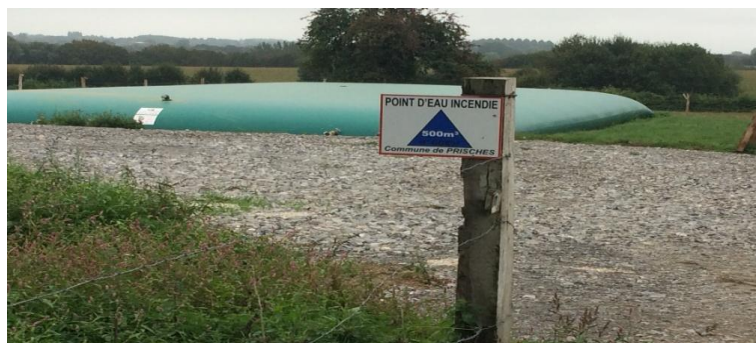
Figure 8 : Réserve incendie avec panneau d'indication
